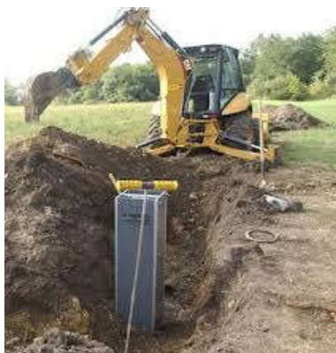
Drenažo nuotėkio reguliavimo šuliniai JAV (Šaltinis: www.agridrain.com )
