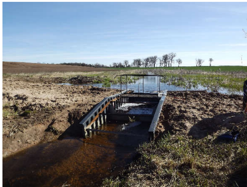
Šlapynės ištekėjimo dalis su gruntine užtvanka ir vandens persiliejiimo nuopyla
