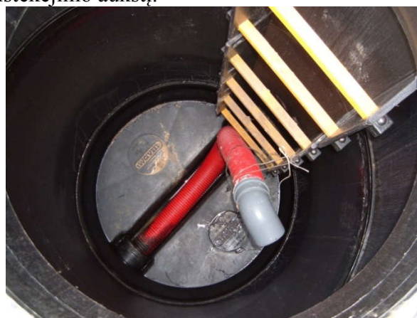
Vandens ištekėjimo lygio reguliavimas lanksčiu arba įtvirtintu vamzdžiu
