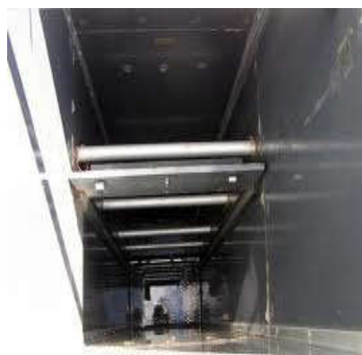
Drenažo nuotėkio reguliavimo šuliniai JAV (Šaltinis: www.agridrain.com )
