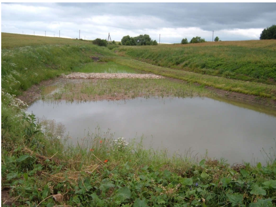
Prieš patenkant paviršiniam vandeniui nuo laukų į ištiesintą upelį, vanduo apvalomas sedimentaciniame tvenkinėlyje (Lietuva)
